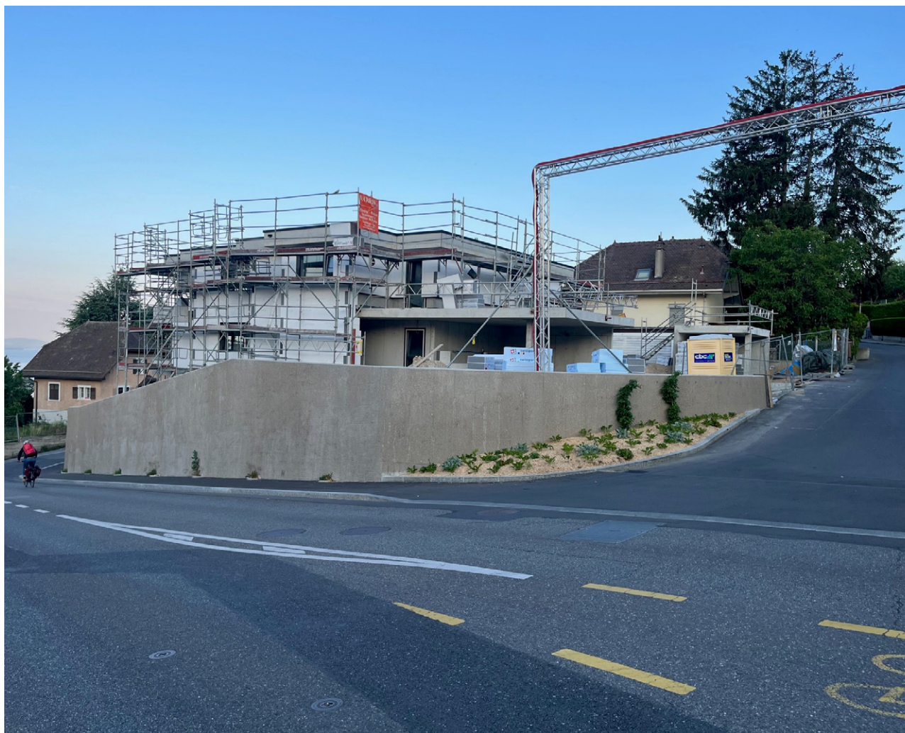
Fin des travaux de la 1 ère étape (source : Ville de Pully)
