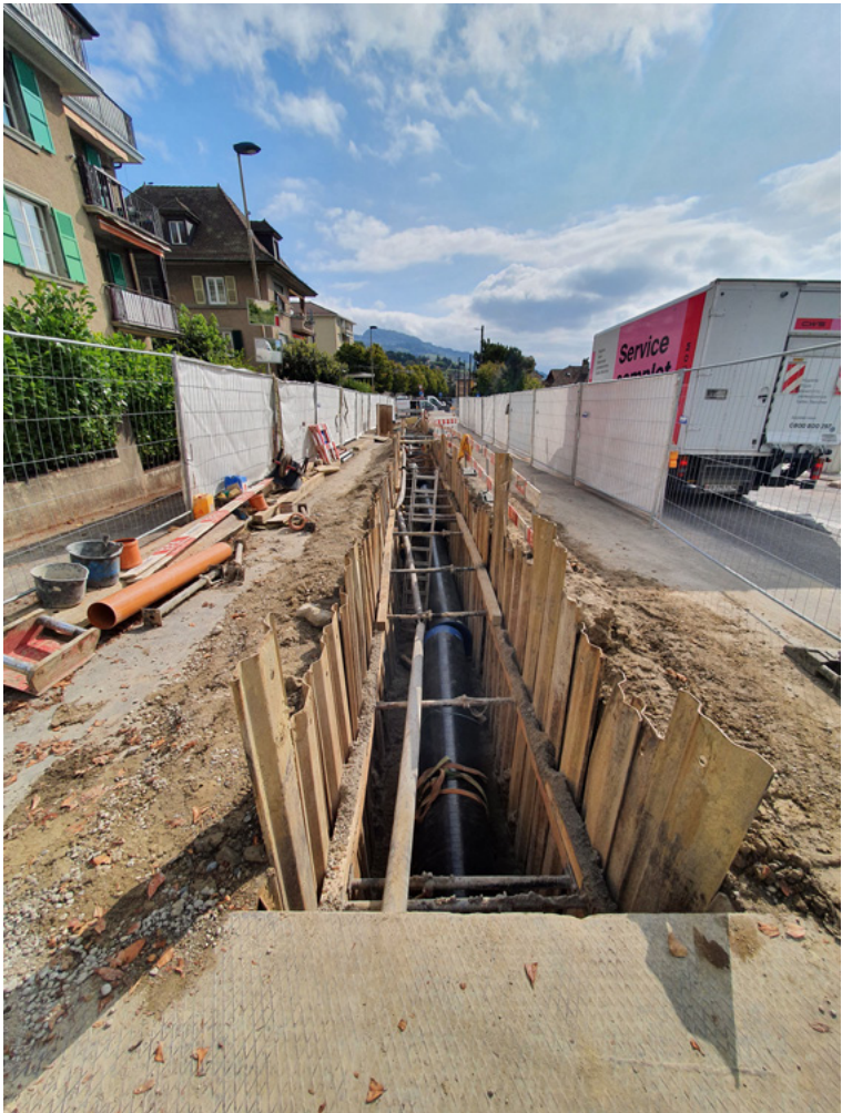
Travaux en cours à l’av. Samson Reymondin © Ville de Pully
